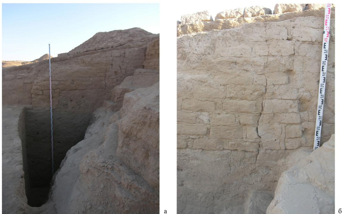
Рис. 11. Пом.21. а) Вид с юга на обрыв материка и стратиграфический разрез нивелировочной подсыпки под пол пом. 21; б) Восточная стена пом.21 в месте разрыва на стыке подсыпного грунта и материкового основания.
